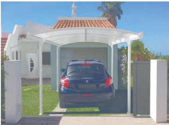
Carport toit cintré
